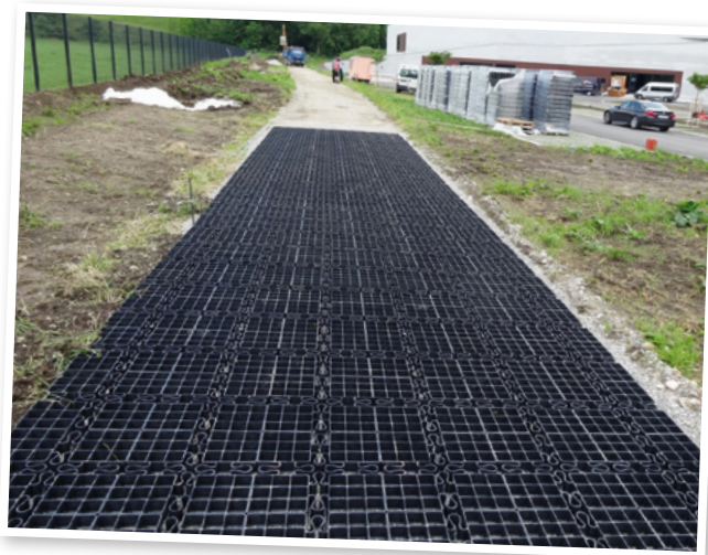
Eenvoudige en snelle plaatsing
